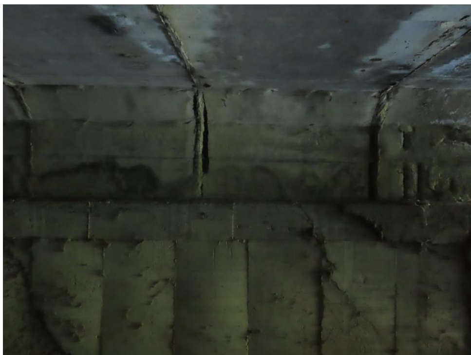
Podhled NK - porušené spárování, průsaky vody, výluhy pojiva
