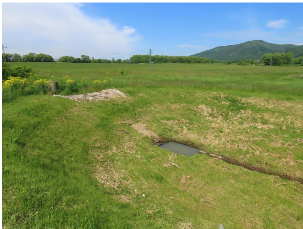
Pohled na stávající jímku, kamenné odláždění a betonovou šachtu situované na vtokové straně
